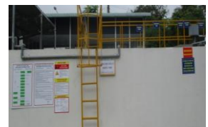
IPAL (Instalasi Pengelolaan Air Limbah) ukuran kecil di VT Dibangun untuk pengolahan air limbah dari non kaku
