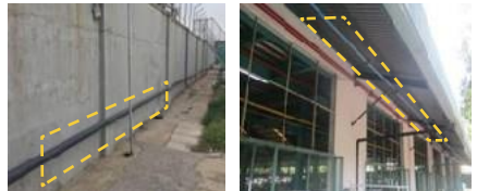
QT/VT ngăn ngừa việc rò rỉ nước bằng cách chuyển đổi từ ống nước ngầm thành ống nước lộ thiên
